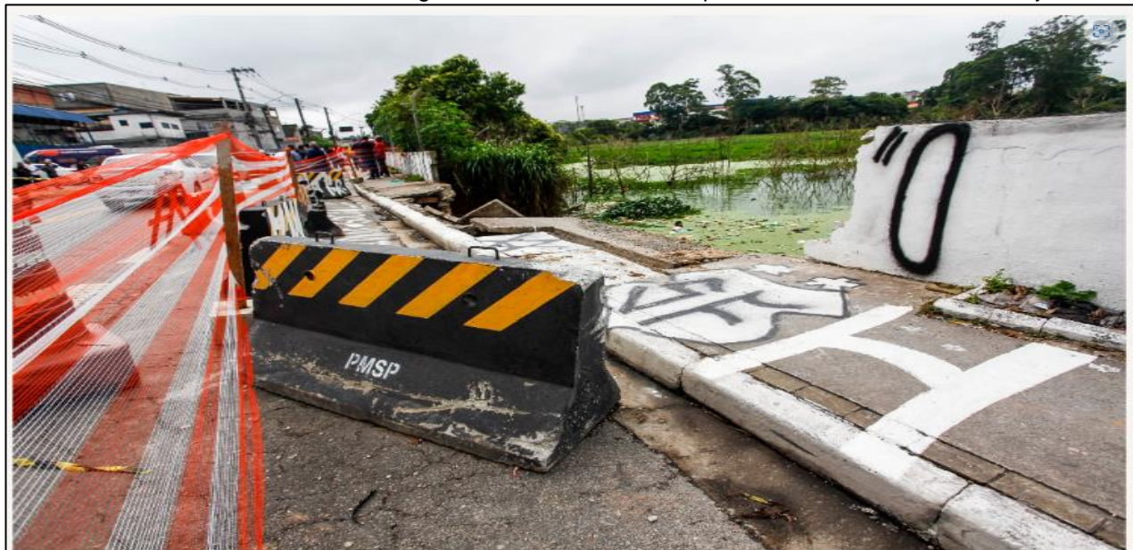
Foto 1 – Trecho da Estrada do Alvarenga sentido centro – bairro que cedeu devido às chuvas de janeiro de 2023
